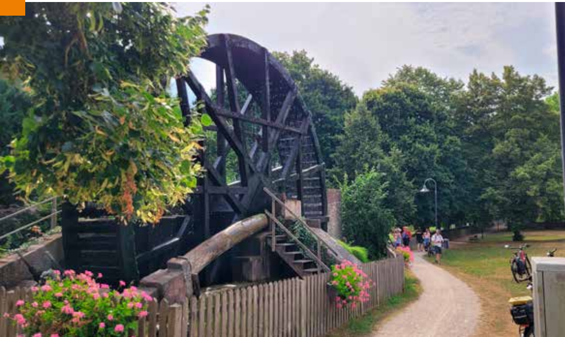
Mit fast 10 Metern Durchmesser eines der größten Wasserräder Europas steht in Bad Nauheim-Schwalheim. Foto: Ralf Gandenberger
